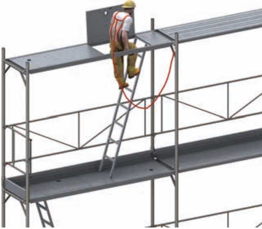
Şekil 22: En üst iskele bölümüne erişmeden önce KKD ile sabitleme.
