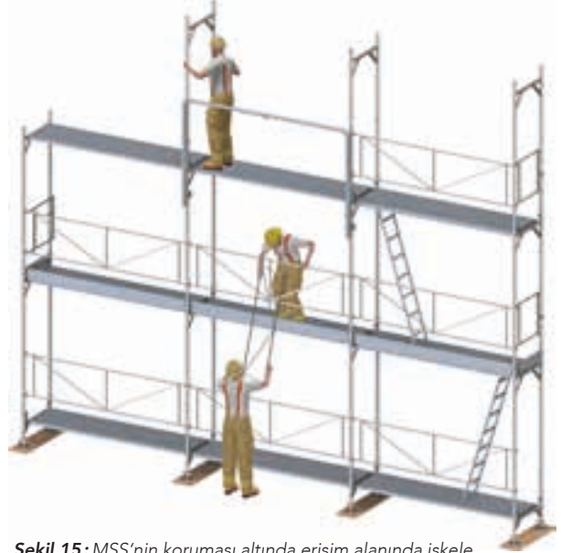
Şekil 15: MSS'nin koruması altında erişim alanında iskele bölmesinin montajı.
