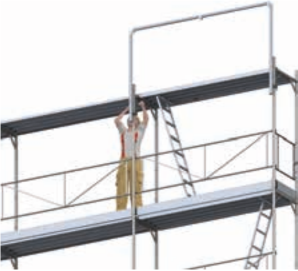
Şekil 14: MSS'nin erişim alanına emniyetli konumdan montajı.
