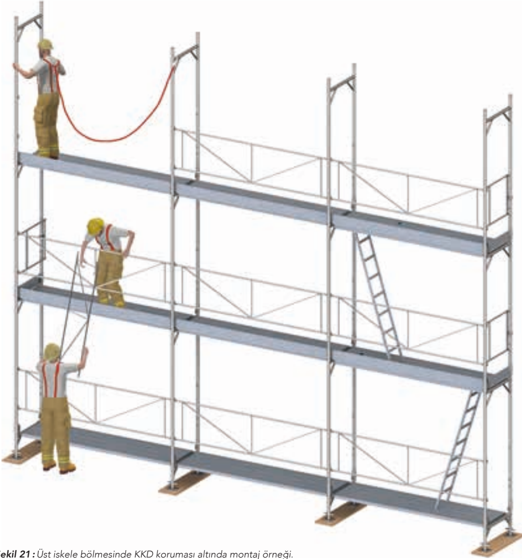
Şekil 21 : Üst iskele bölümünde KKD koruması altında montaj örneği.
